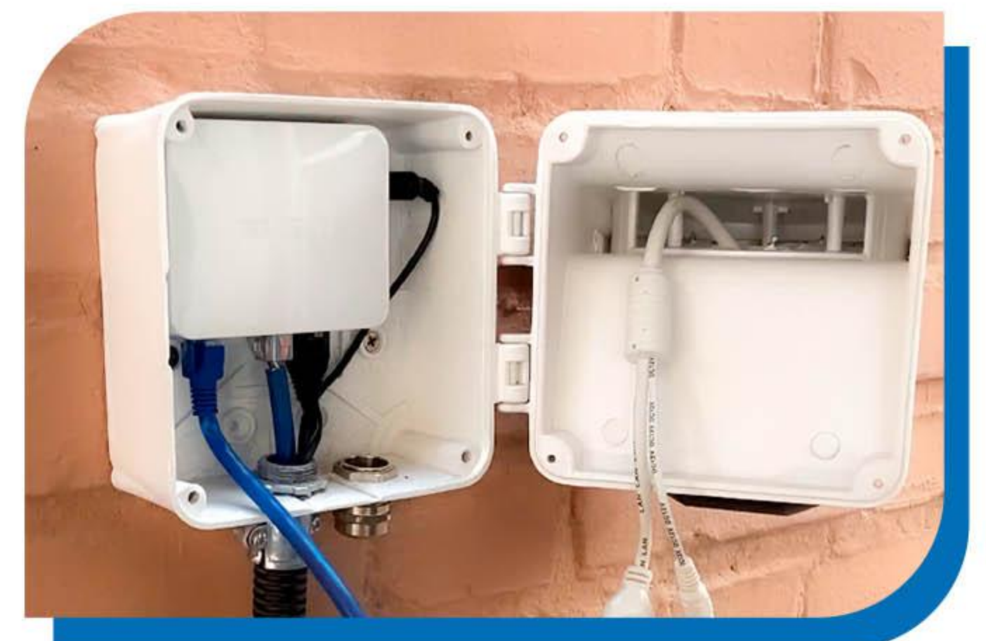
فضای مناسب آداپتور و سوئیچ
